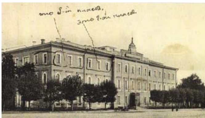
Здание ЕМГ с пометками гимназиста Виктора Муравьева. 1913 г.
